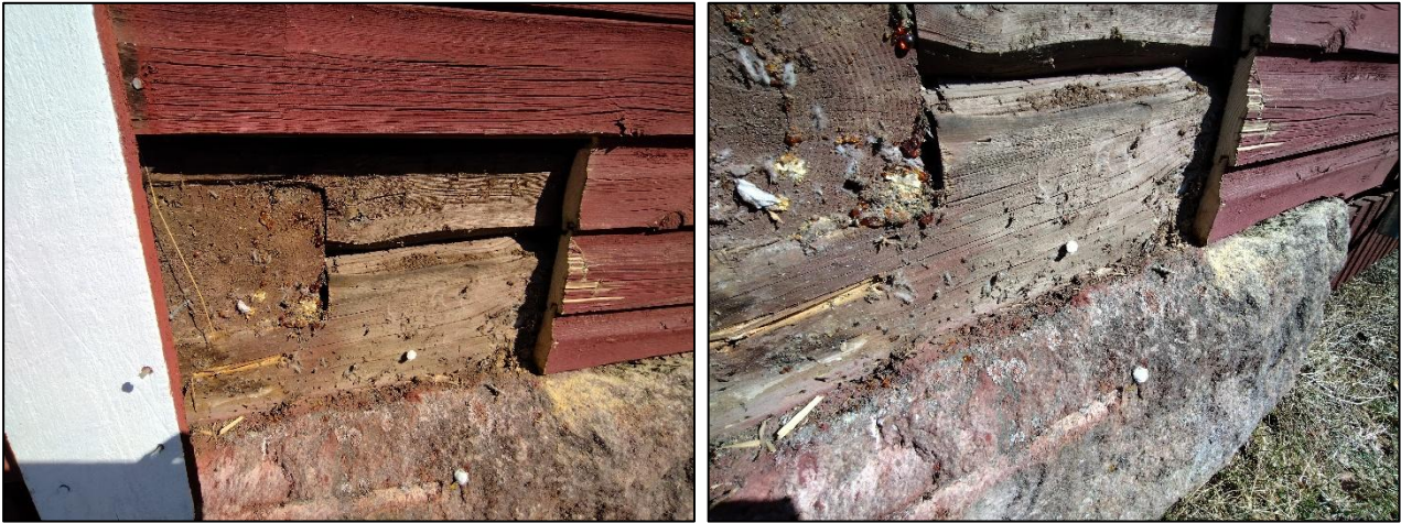
Kuva 2.2. Yleiskuvia rakenneavauksesta AV3.
