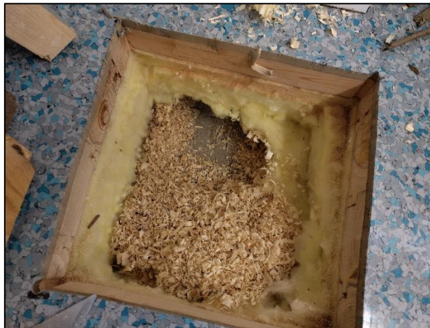
Kuva 2.1. Yleiskuva rakenneavauksesta AV1.
