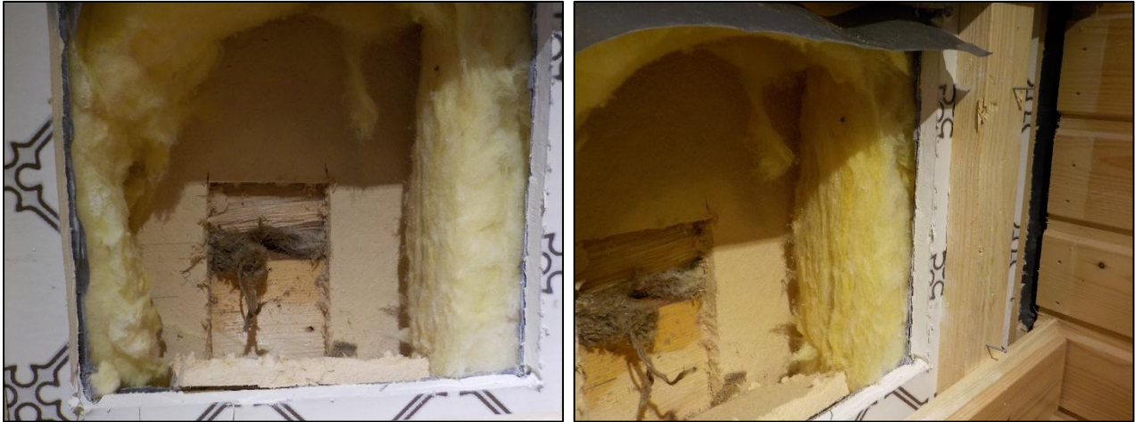
Kuva 2.8. Yleiskuvia rakenneavauksesta AV4.
