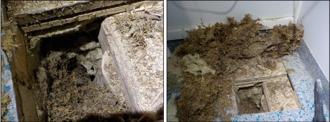
Kuva 2.2. Yleiskuvia rakenneavauksesta AV1.
