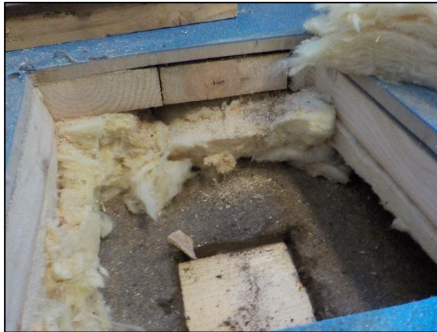
Kuva 2.4. Yleiskuva rakenneavauksesta AV5.
