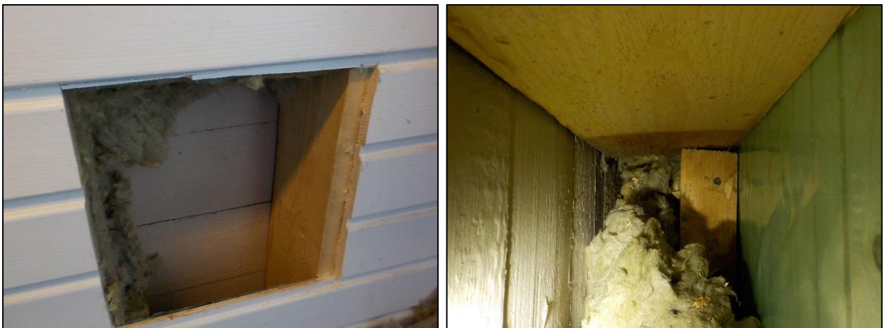
Kuva 2.9. Yleiskuvia rakenneavauksesta AV6.
