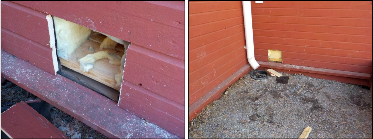
Kuva 2.11. Yleiskuvia rakenneavauksesta AV9.
