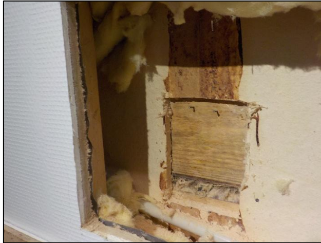
Kuva 2.7. Yleiskuva rakenneavauksesta AV2.
