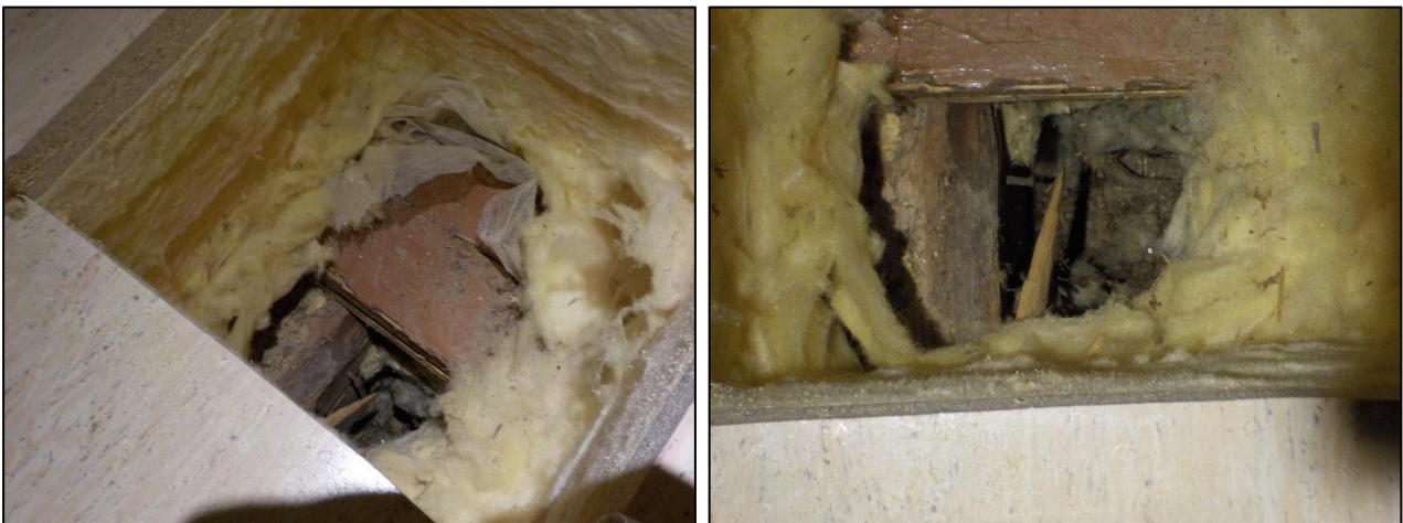
Kuva 2.3. Yleiskuvia rakenneavauksesta AV3.
