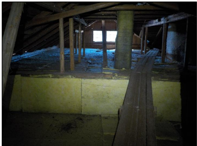
Kuva 2.13. Katon jiiressä on korjaamaton kattovuotovaurio. Oikealla on yleiskuvaa yläpohjasta.
