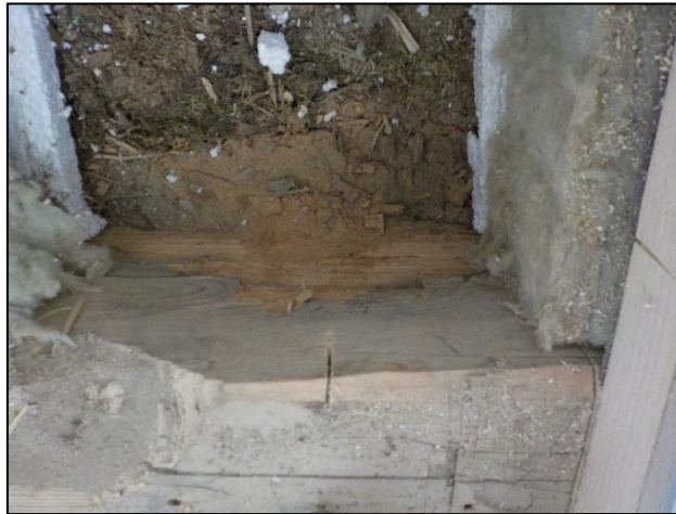
Kuva 2.5. Yleiskuva rakenneavauksesta AV7.
