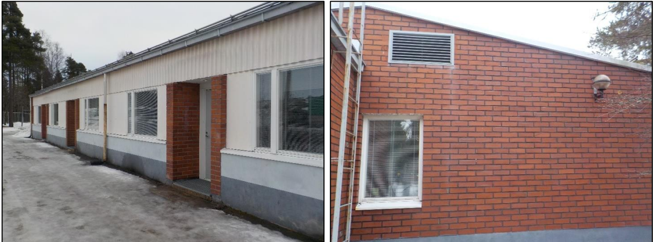
Kuva 2.11. Yleiskuvia eri julkisivumateriaaleista.
