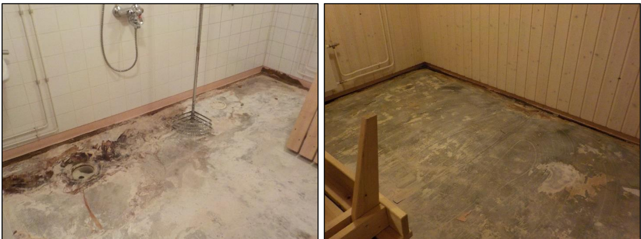
Kuva 2.4. Muovimatto on jo purettu kellarin pesutilojen lattioista.
