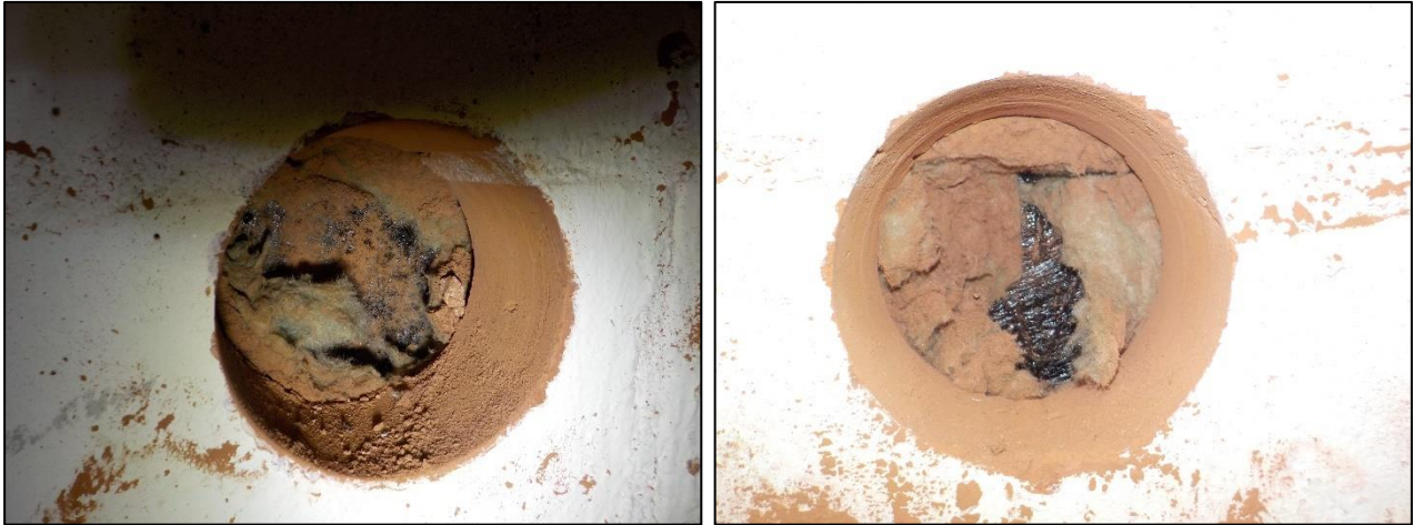
Kuva 2.7. Yleiskuvat rakenneavauksista AV2 ja AV3.
