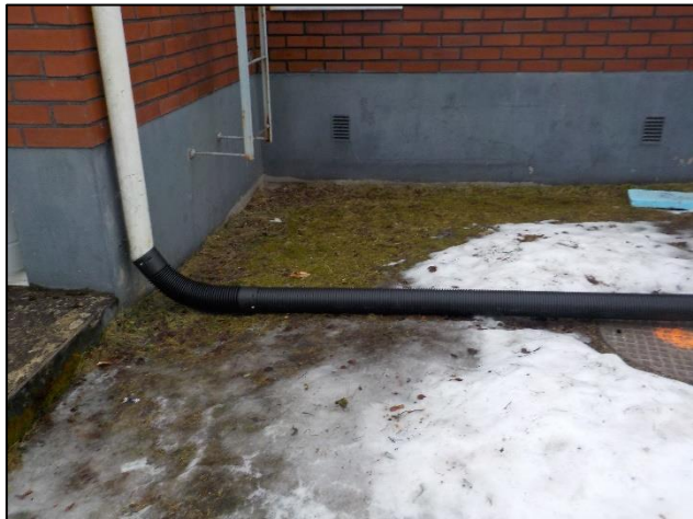
Kuva 2.1. Yleiskuvia piha-alueesta: tontti rakennuksen ympärillä on melko tasainen. Nykyisellään katto-vesiä ohjataan vaihtelevan mittaisilla putkilla etäämmäksi sokkeleista ja rakennuksesta.
