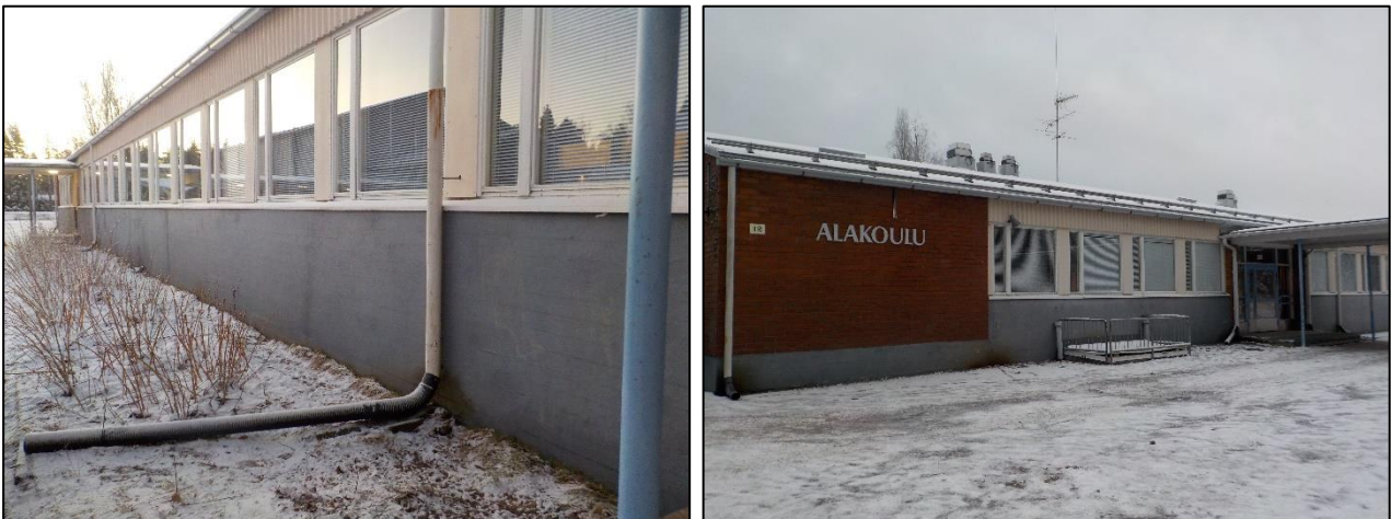
Kuva 2.1. Yleiskuvia piha-alueesta: tontti rakennuksen ympärillä on melko tasainen. Nykyisellään kattovesiä ohjataan vaihtelevan mittaisilla putkilla etäämmäksi sokkeleista.
