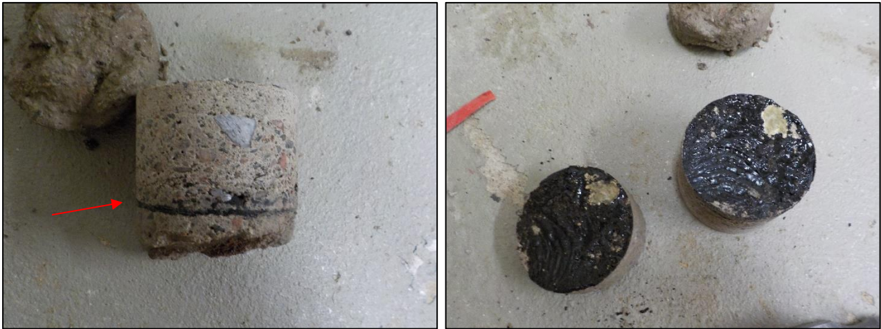
Kuva 2.2. Yleiskuvia kellarin alapohjarakenteen porauslieriöistä. Bitumisively erottui rakenteesta selkeästi.
