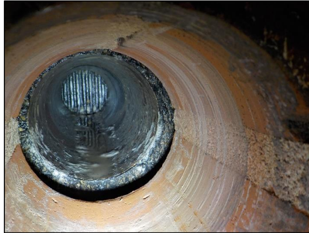
Kuva 2.9. Yleiskuva rakenneavauksesta AV2.
