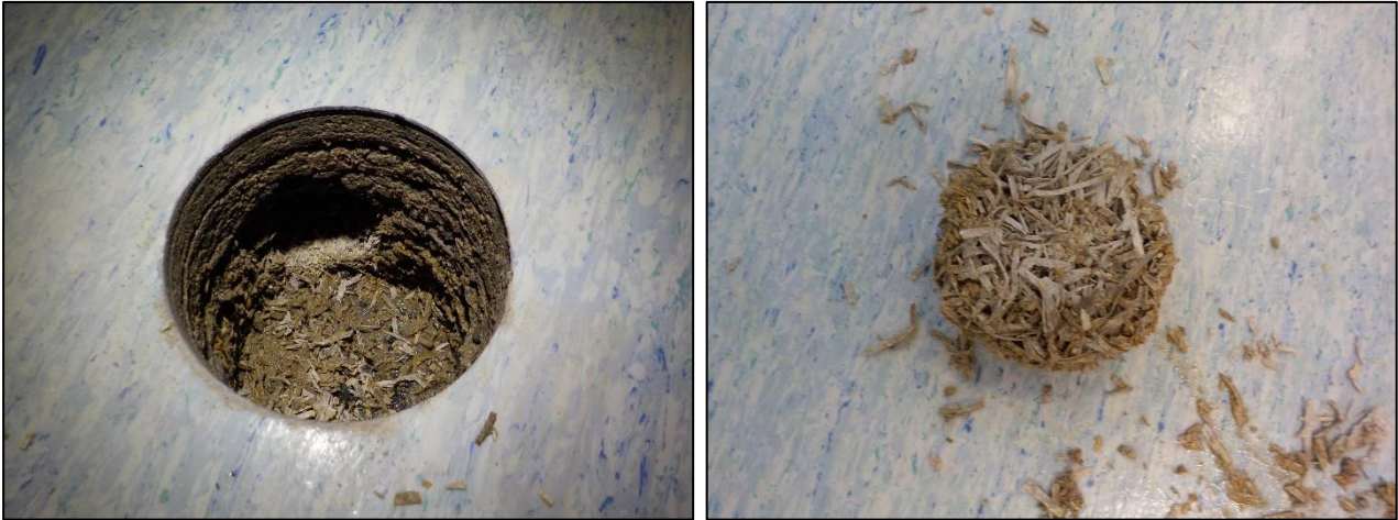
Kuva 2.3. Yleiskuva rakenneavauksesta AV12.
