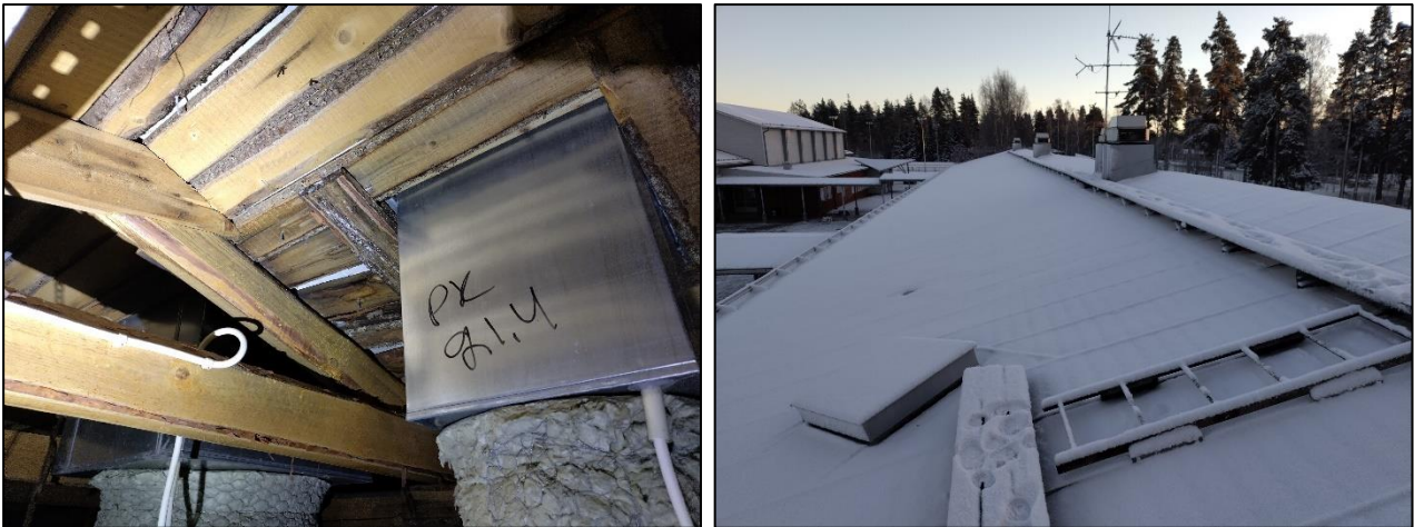
Kuva 2.22. Yleiskuvia huippumureihin liittyen: ikä vaihtelee ja kolmessa huippumurissa havaittiin selkeä laakerivika.
